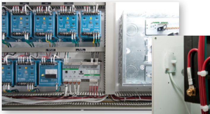
图2, PGR-8800电弧继电器和光传感器的典型安装
