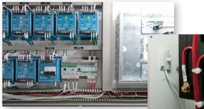
Abbildung 2. Typische Installation des PGR-8800 Lichtbogenwächters und des Lichtsensors.
